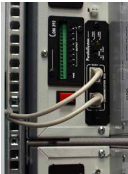
Параллельное подключение и плата контактов программируемых реле
